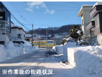
※作業後の街路状況
