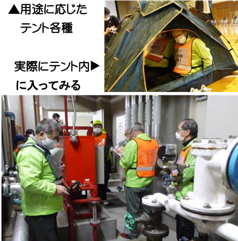
校内貯水槽設備を確認する▲
